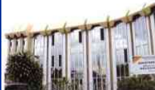
Poste de Ebolowa
