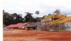
Nouvel Hôpital Sangmellem
